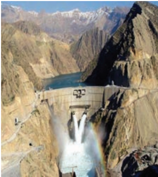
شکل ۴-۶- سد کارون ۳ بلندترین سد بتنی کشور
