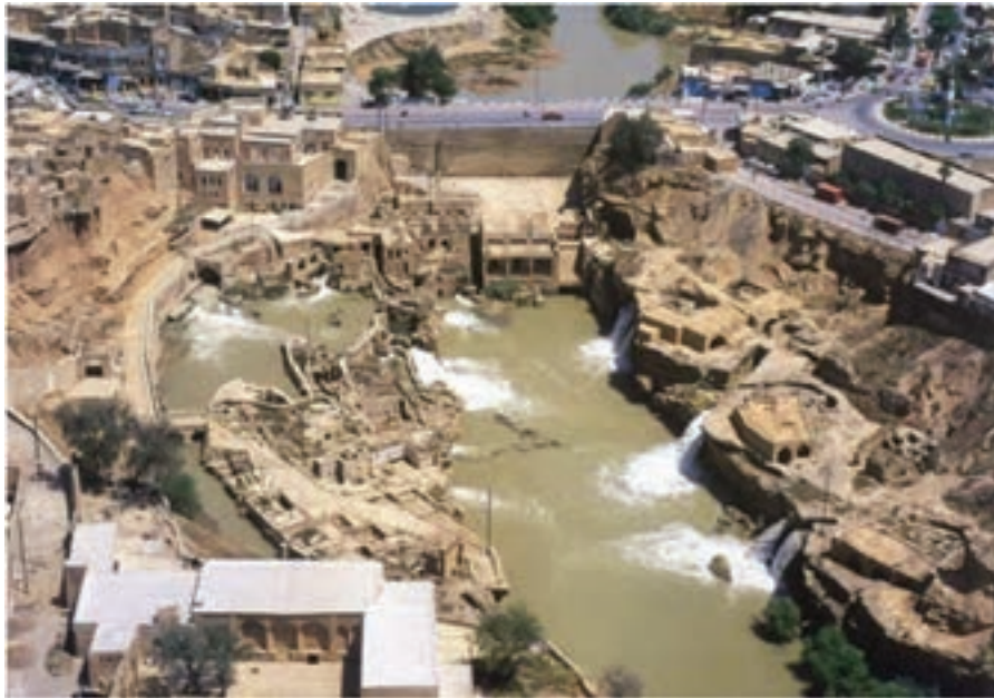
شکل ۱۳-۵- سازه‌های آبی شوستر
