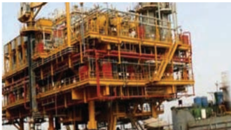
شکل ۳۶-۵- ساخت سازه و سکوهای دریایی در خرمشهر
