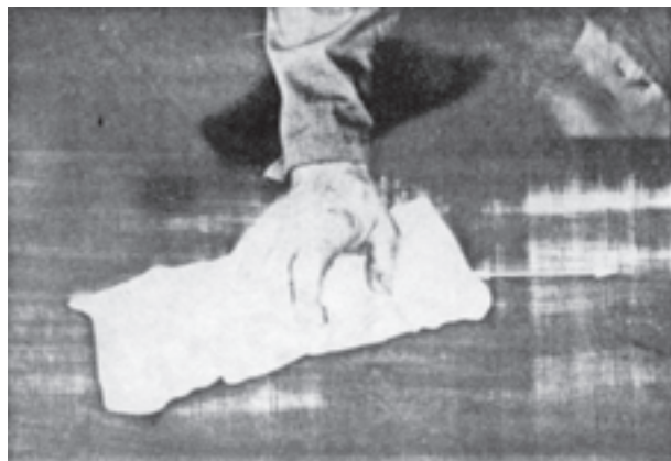
شکل ۱۲-۳۸- تمیز کردن سطوح پرداخت شده به وسیله پارچه خشک
