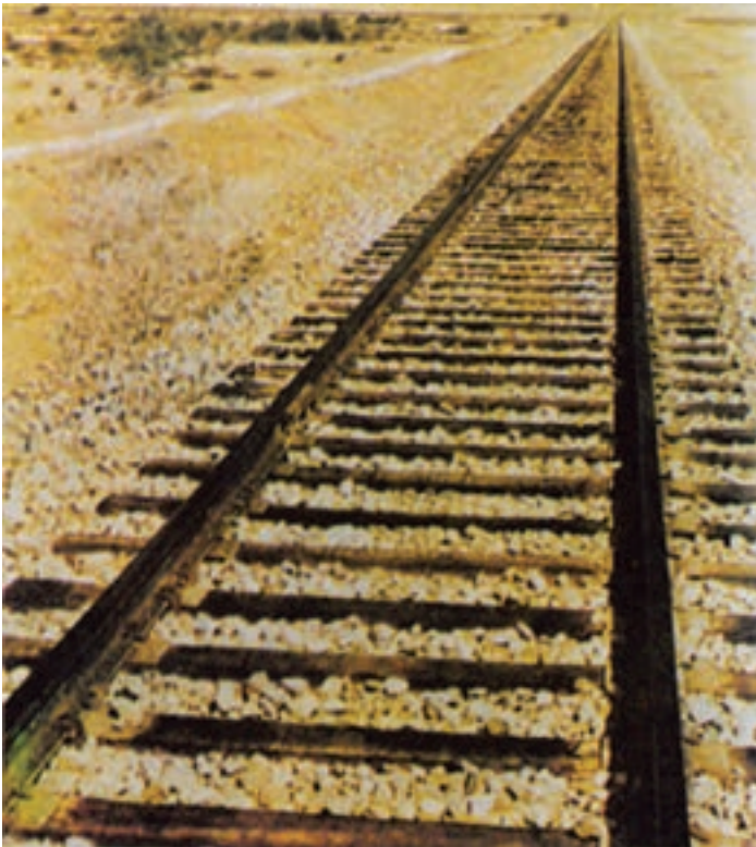
شکل ۱-۶- تراورس راه آهن اشباع‌شده با کرئوزوت
