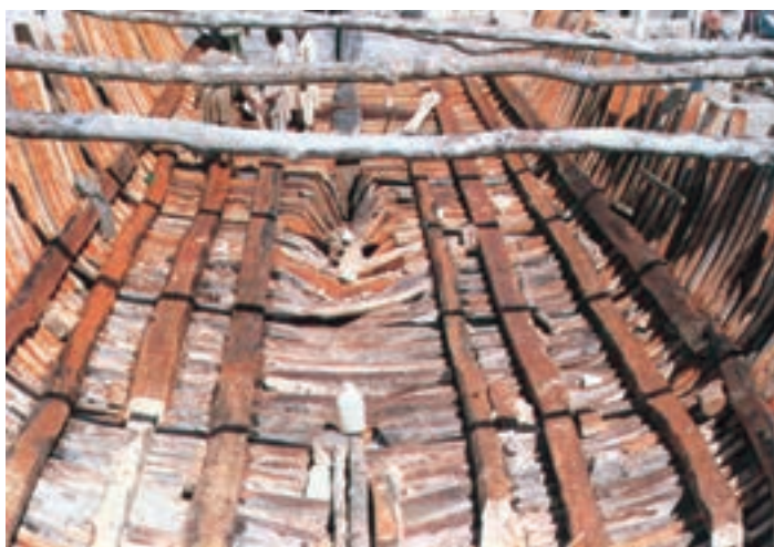
شکل ۱۳-۲- نصب تیرهای طولی روی فریم‌ها
