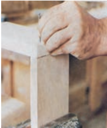
شکل ۱۰۲-۵- بعد از کوبیدن میخ آنرا با سنبه بکوبید.
