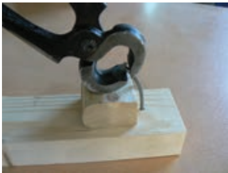
میخ کشی با گازانبر با استفاده از تکیه گاه
