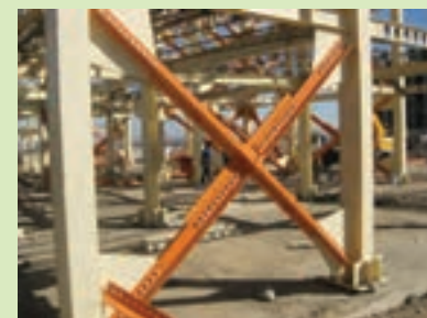
اجرای اتصال بادبندها از نوع پیچی
