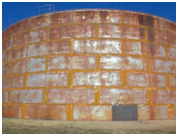
شکل ۳-۱- ساخت مخزن ذخیره سوخت با ورق های فولادی
