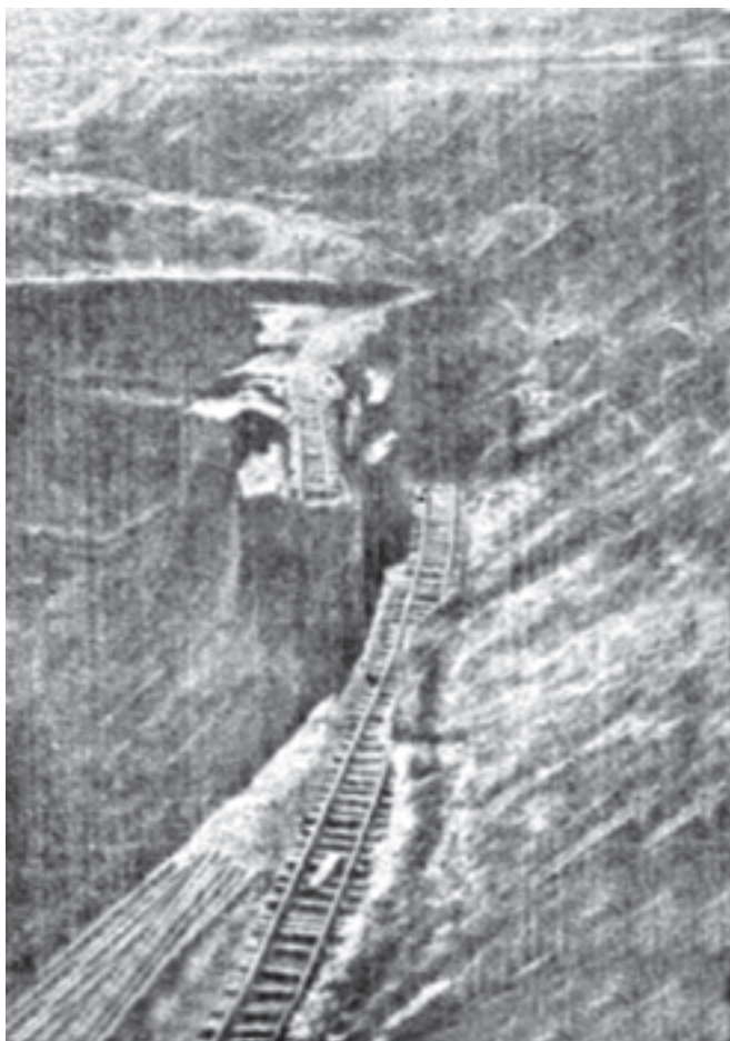
شکل ۳-۱۰- تخریب ریل خط آهن معدنی در اثر ریزش یک دامنه
