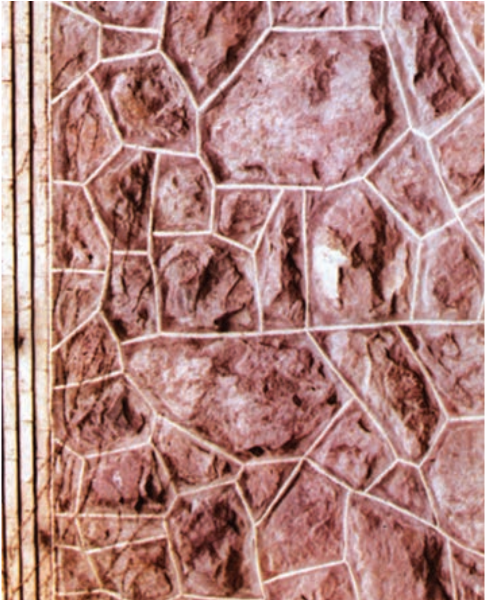
شکل ۲-۵- نمونه‌ای از کاربرد سنگ‌ها در دیوار ساختمان
