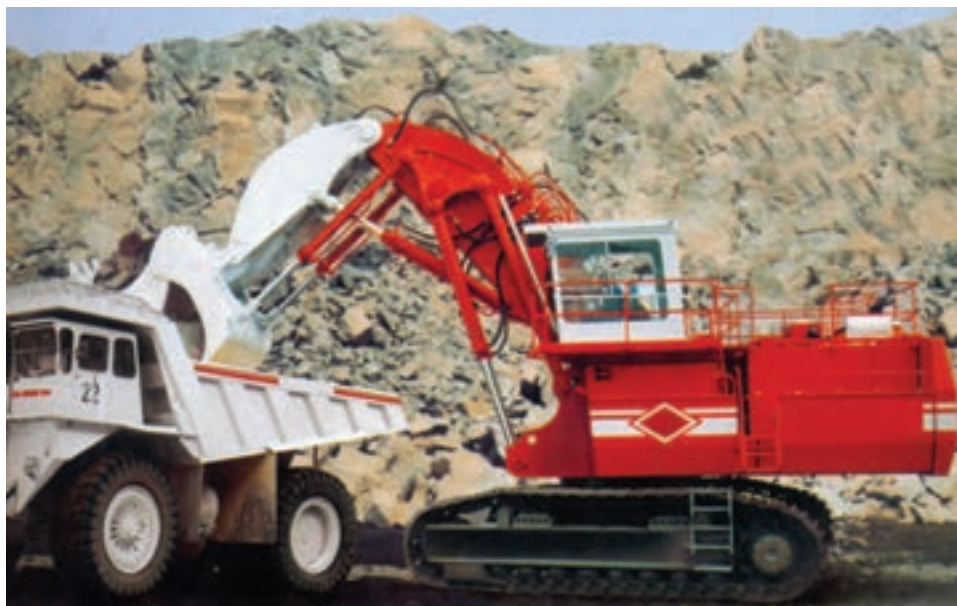
شکل ۱۹-۴- بیل مکانیکی در حال بارگیری
