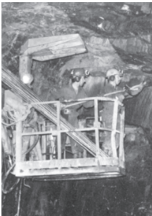
شکل ۲-۲۸- طریقه‌ی نصب پیچ سنگ
