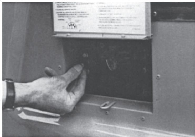
شکل ۱۵-۱۵- شیر استارت بار (Start/run) دو طرفه
