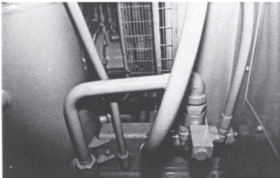
شکل ۴-۱۵- رادیاتور روغن
