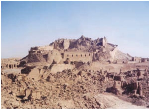
(ب) ارگ بم بعد از زلزله
