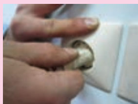
شکل ۳-۳۳ روش درست بیرون کشیدن دوشاخه
