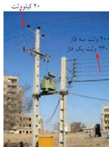
شکل ۱-۷ تبدیل ولتاژ ۲۰ کیلوولت به ۴۰۰ و ۲۳۰ ولت.
