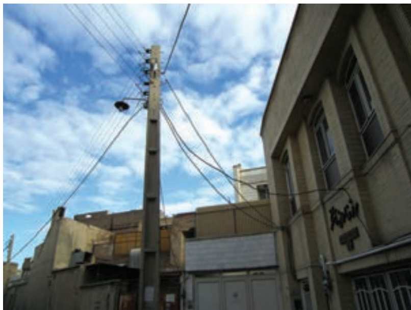
شکل ۱-۹ چگونگی اتصال برق منازل مسکونی.
