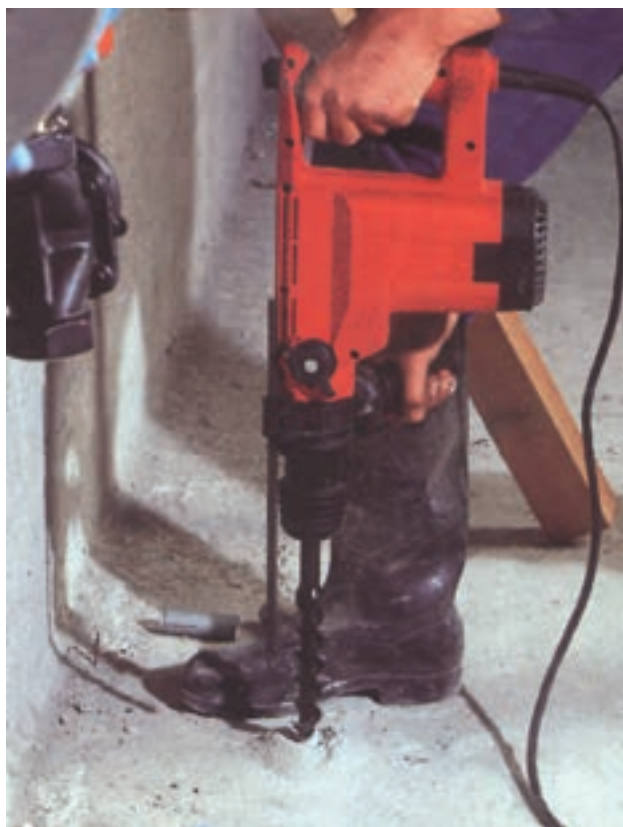
شکل ۵-۱۶- استفاده از کفش مناسب در حال کار
