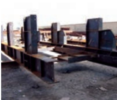
شکل ۱۱-۱۵- فیکسچر مونتاژ نهایی قطعات الماکی دستک‌ها روی ستون صلیبی شکل
