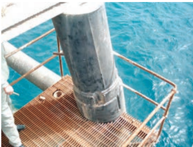
استفاده از پوشش قیری در سازه دریایی
