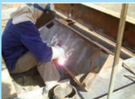
جوش طولی به روش دستی
