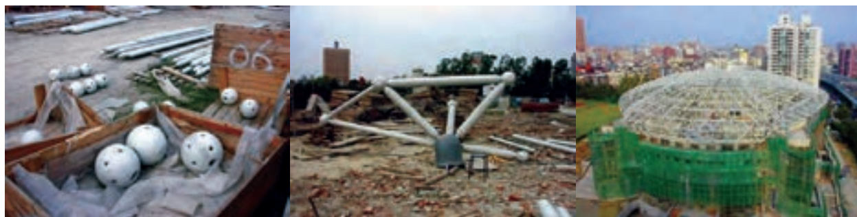
شکل ۱۰-۱۵- نمایی از یک خریای فضایی
