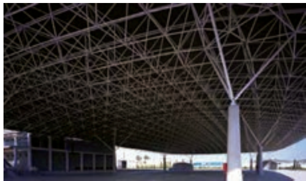
استفاده از فرپا در سازه سقف عریض
