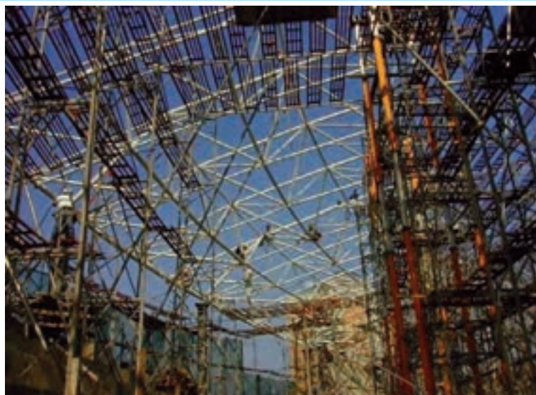
شکل ۱۰-۱۷- نمونه‌ای از سازه با فرپای فضاکار
