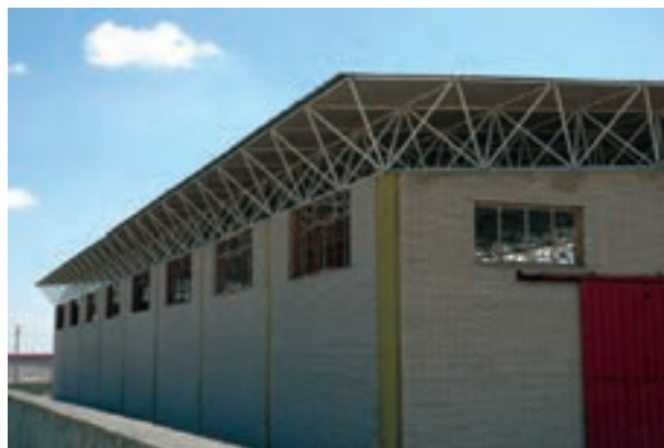
شکل ۱۰-۱۸- نمونه‌ای از فرپای فضایی
