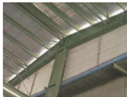
شکل ۱۰-۳۱- اجرای مهاربند افقی در قاب شیبدار
