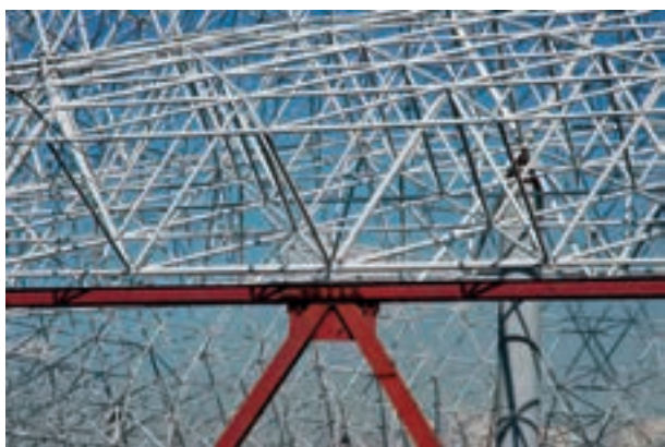
شکل ۱۰-۲۰- نمونه‌ی اتصال اعضای فرپای فضاکار
