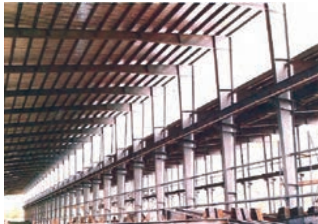
ب- قاب فلزی (سوله) دو دهانه با ستون مشترک و ریل جرثقیل سقفی
