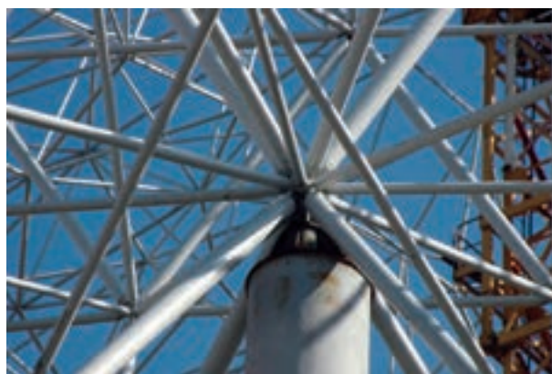
شکل ۱۰-۲۰- نمونه‌ی اتصال اعضای فرپای فضاکار
