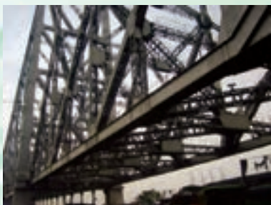
کاربرد المان خرابایی در سازه پل فولادی
