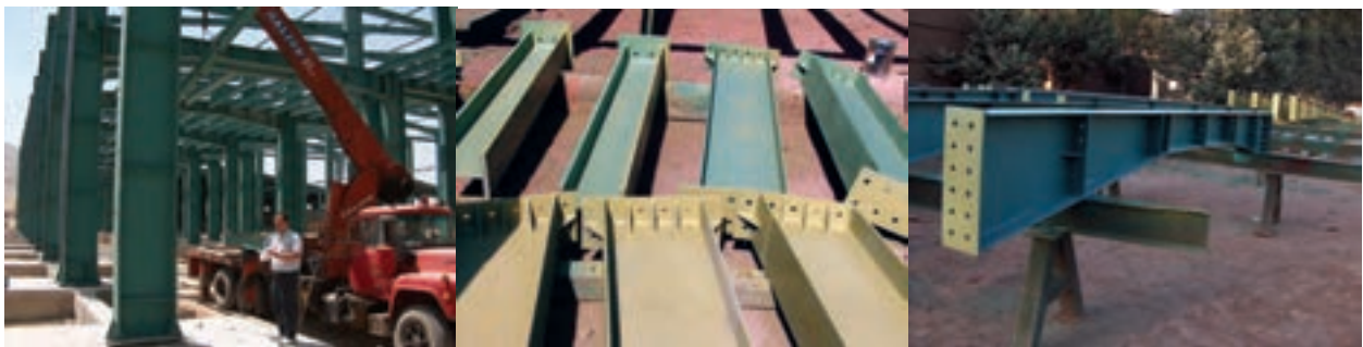
سافت و نصب اسکلت صنعتی
