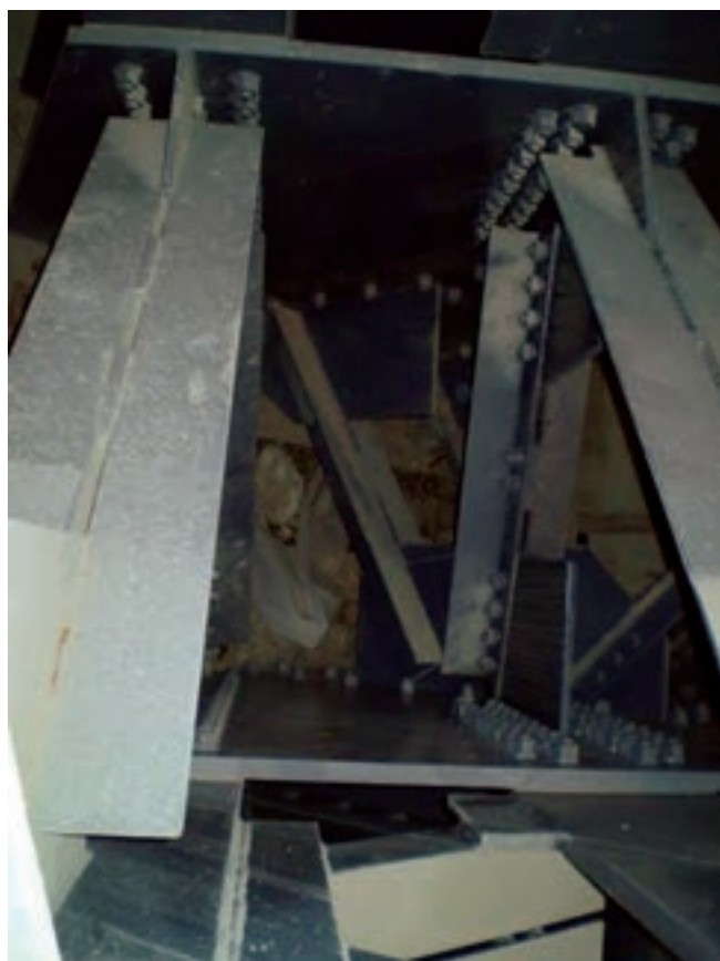
شکل ۶-۱۰ - اتصال پیچ و مهره‌ای اعضای فرپاها
