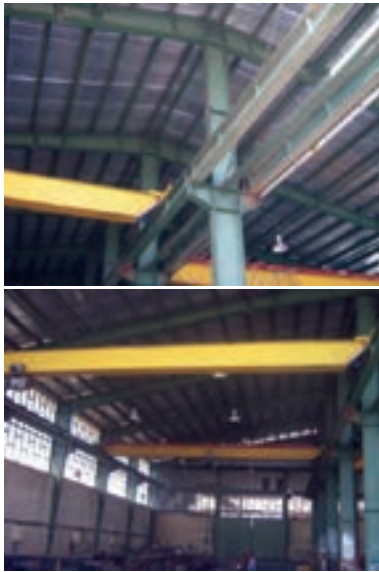
پ- کاربرد جرثقیل سقفی در ساختمان صنعتی
