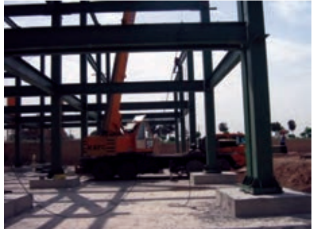
شکل ۹-۲- قاب فمشی در سازه فولادی
