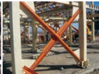
الف- مهاربندهای همگرا در اسکلت فولادی
