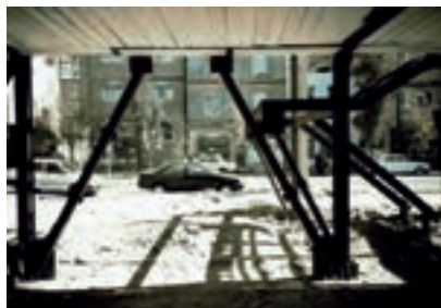
ب- مهاربند ذوزنقه واگرا در اسکلت فولادی
