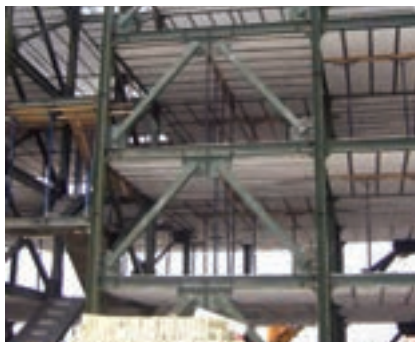
شکل ۹-۴- انواع مهاربند قائم در ساختمان
