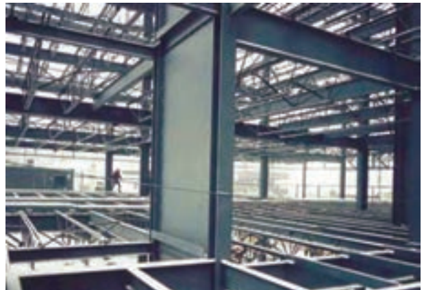
شکل ۹-۳- دیوار برشی بتنی در سازه فولادی
