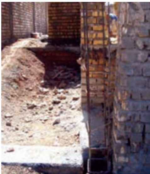
شکل ۹-۷- یک ساختمان با مصالح بنایی در حال سافت
