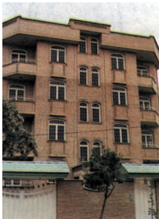
شکل ۶-۱۰- اجرای قوس در نمای آجری
