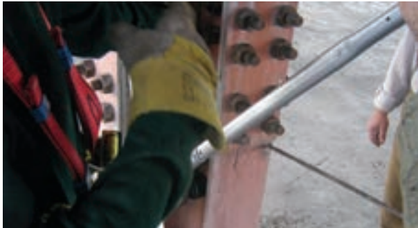
شکل ۷-۳- استفاده از پیچ‌های پرمقاومت در اتصالات
