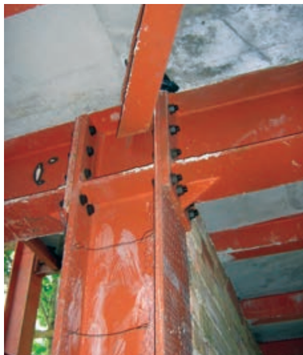
شکل ۷-۸- اتصال پیچی در سافتمان اسکلت فولادی
