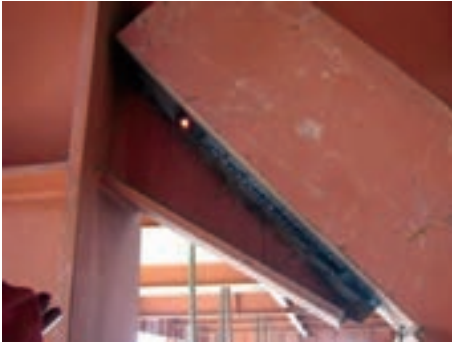
نمونه‌ای از اتصال جوشی در مهاربند سافتمان
