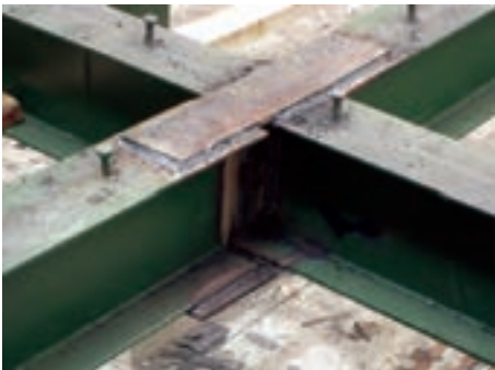
نمونه‌ای از اتصال جوشی در اتصال تیر به تیر
