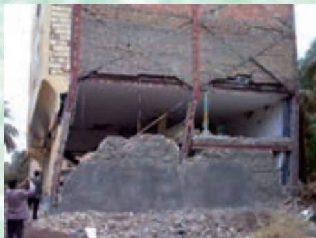
استفاده از مهاربندی ضعیف در یک جهت سازه که منجر به تغییر شکل زیاد سازه شده است
