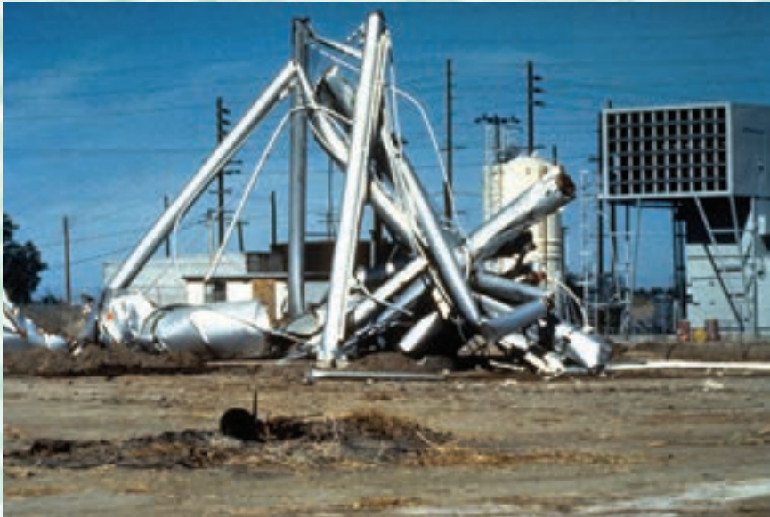
تخریب مخزن هوایی در اثر زمین لرزه به دلیل لاغری زیاد تیرها و اعضای قطری
