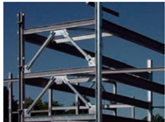
شکل ۱-۶- مهاربندهای معمول مورد استفاده در ساختمان (اعضای فرعی)
