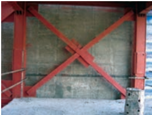
شکل ۱-۶- مهاربندهای معمول مورد استفاده در ساختمان (اعضای فرعی)
