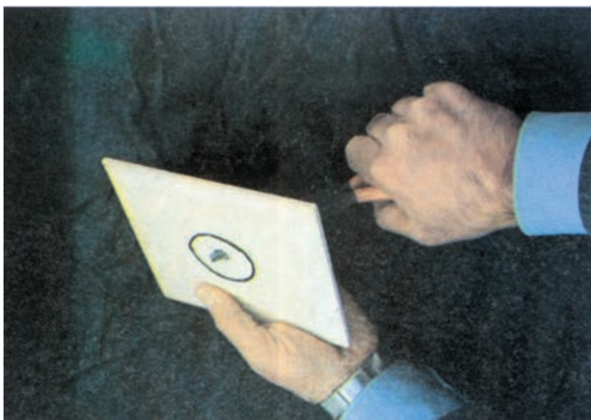
شکل ۸-۶- نحوه ی سوراخ کردن کاشی به وسیله ی انبردست از ناحیه ی پشت کاشی
