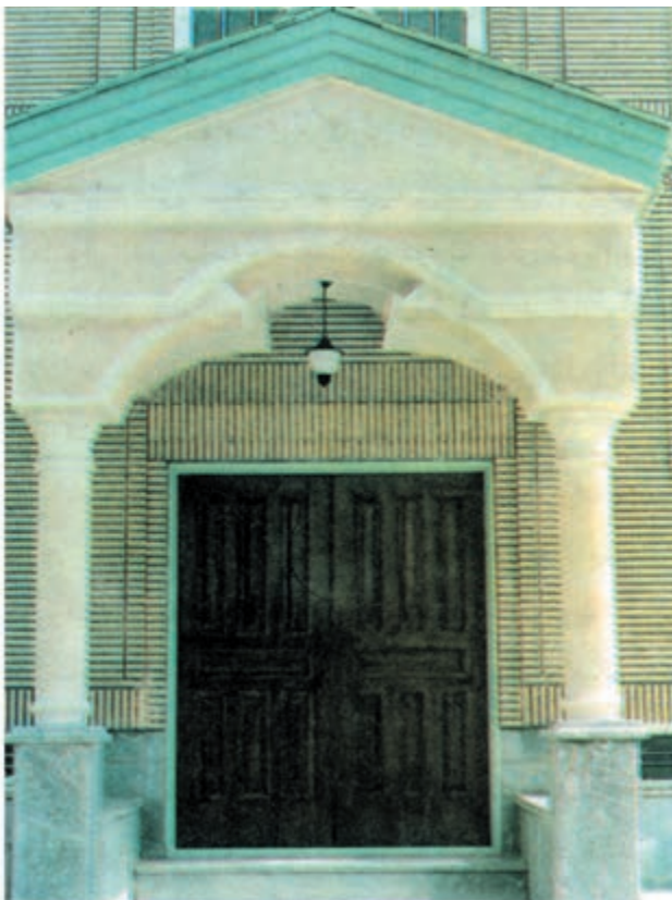
شکل ۲۰-۵- ستون‌سازی - سرستون‌سازی - قوس‌سازی سه کمانه - ابزارزنی - سیمان‌بری
