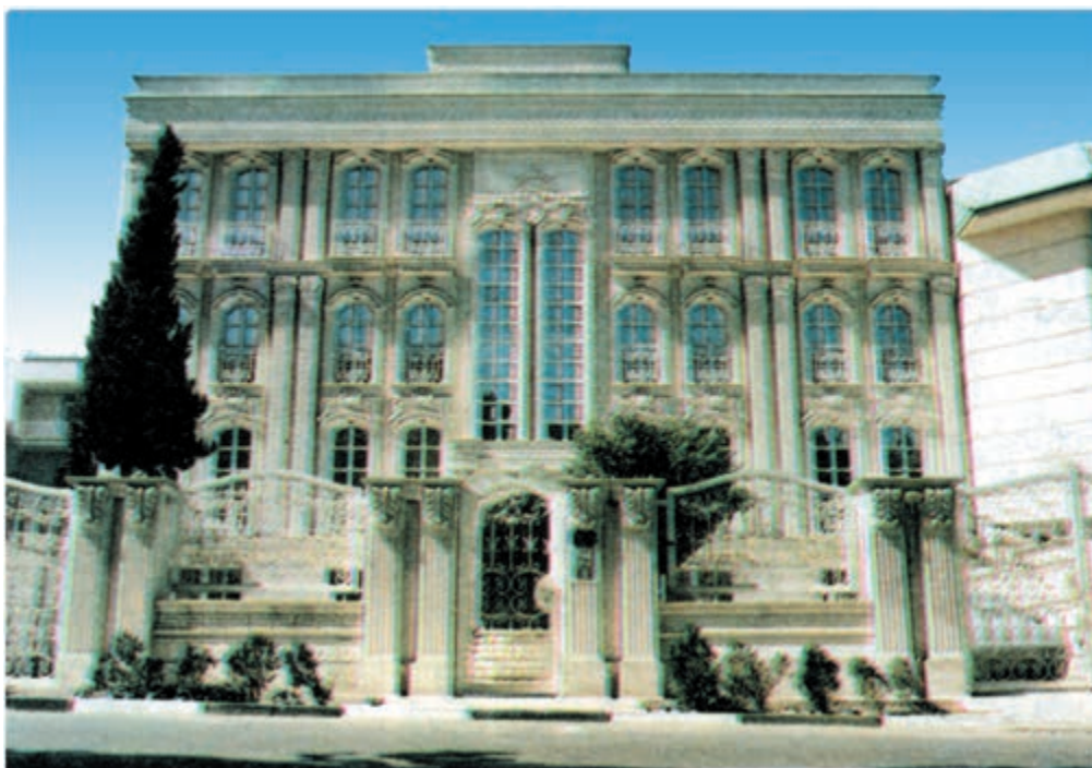
شکل ۲۱-۵- اجرای سیمان‌بری باروک
