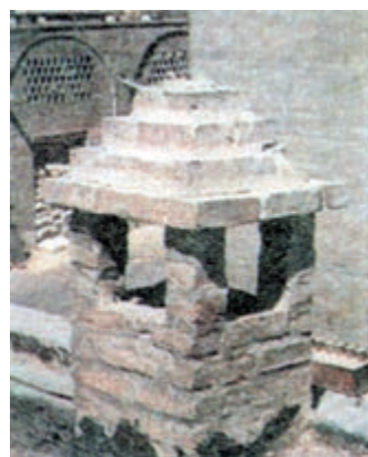
شکل ۳-۶- دودکش و هواکش در ساختمان
