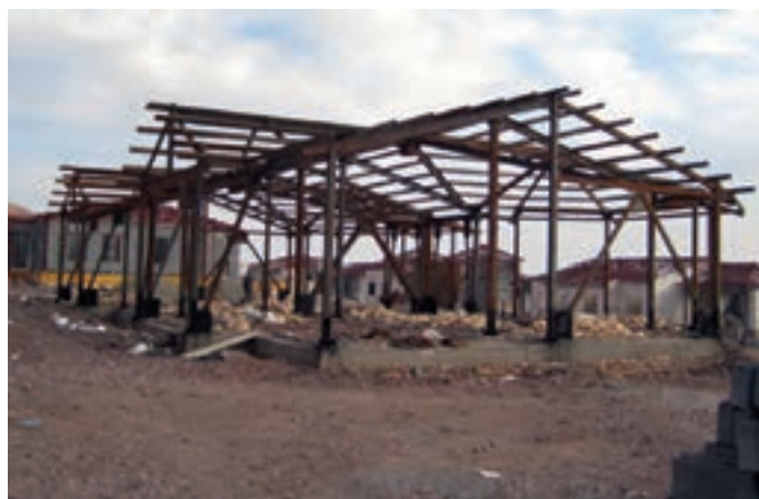
شکل ۴-۲- نمونه اسکلت فولادی شامل اعضای فشاری
