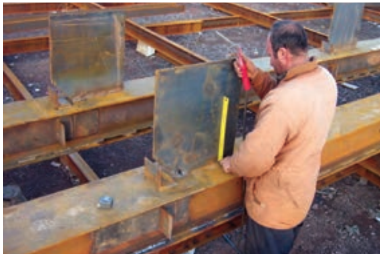
شکل ۴-۲۲- نصب مملقات ستون روی شاسی‌های مونتاژ
