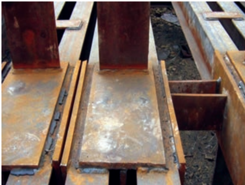
شکل ۴-۲۳- جزئیات ورق اتصال در قاب‌های فمشی
