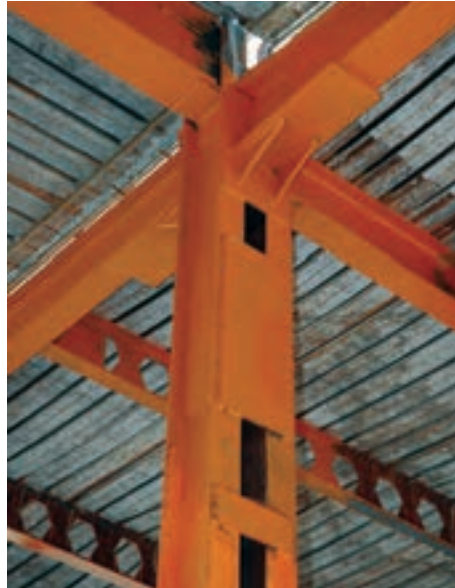
شکل ۴-۲۱- اتصال تیر به ستون دابل پا باز
