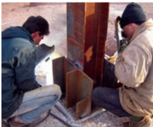
شکل ۴-۲۶- جوشکاری کامل پای ستون و مملقات آن
