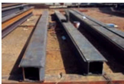
شکل ۴-۱۶- ستون دوبل با ورق تقویتی یکسره
