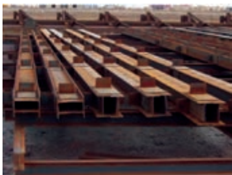
شکل ۴-۱۴- ستون با پروفیل جفت
