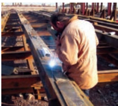
شکل ۴-۱۵- جوشکاری ستون جفت (وی شاسی کار)
