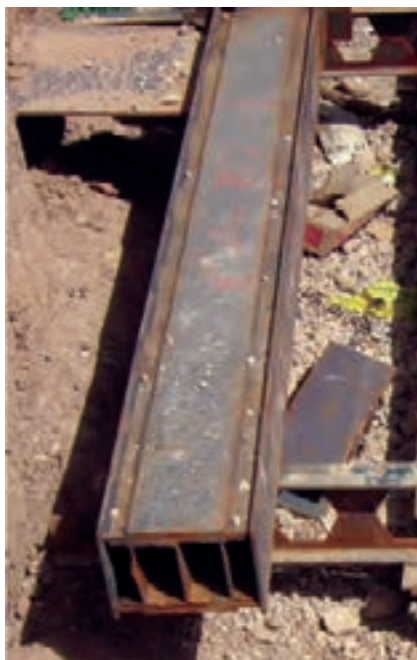
شکل ۴-۱۸- مقطع مرکب سه‌تایی با ورق تقویتی
