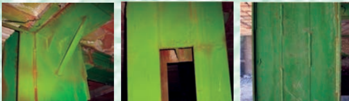
ستون با مقطع مرکب سه تایی در محل اتصال فمشی و ورق تقویتی روی بال آن
