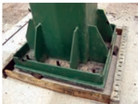
ب - نصب ستون و قالب بندی جهت گروت ریزی
