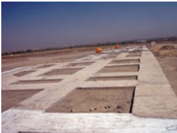
الف- اجرای بتن مگر
