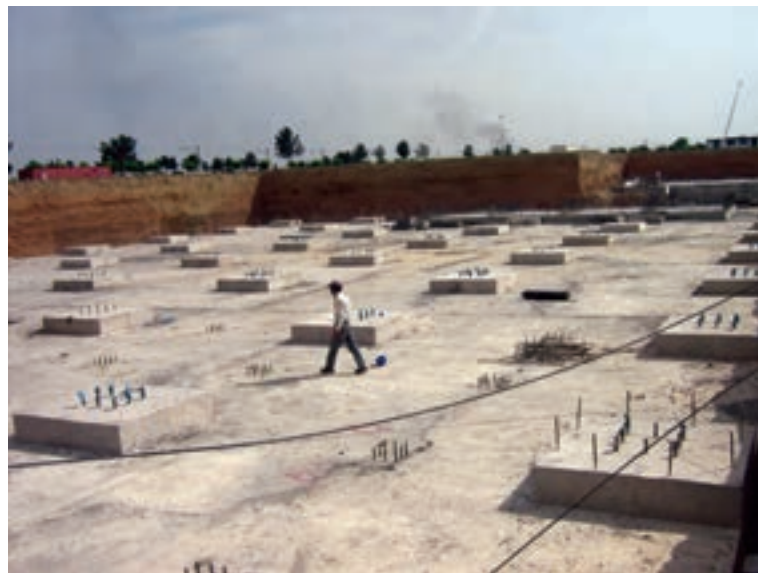
شکل ۷-۳- شالوده‌ی گسترده و کتیبه‌های روی آن
