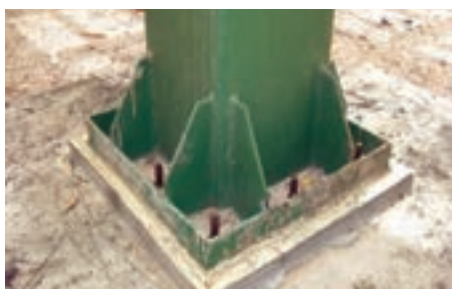
پ - پای ستون پس از گروت ریزی
