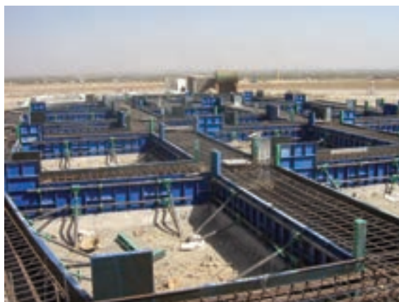
شکل ۳-۱۰- مراحل اجرای شالوده
