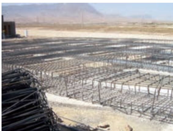
ب - آرماتوربندی شالوده قبل از قالب بندی
