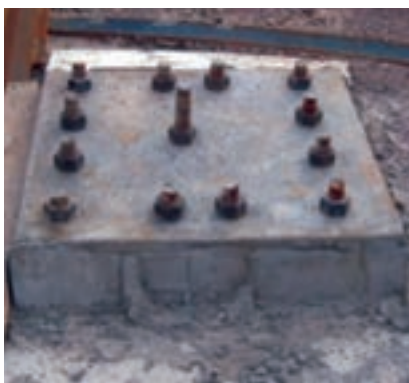
(ب) پس از بتن‌ریزی
