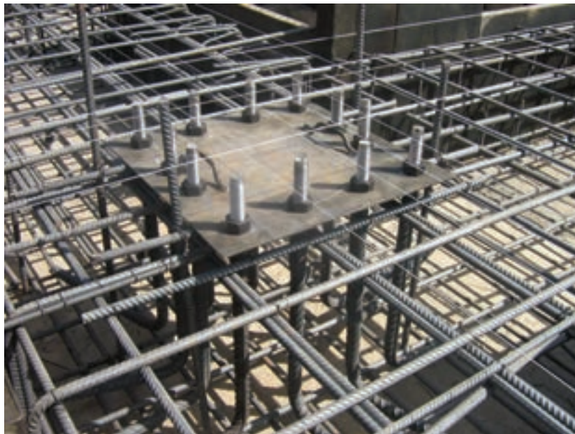
شکل ۳-۱۲- تنظیم پیچ‌های مهاری با شابلن و ریسمان
