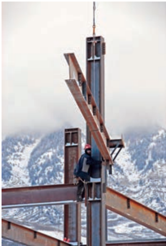
اجرای اسکلت فولادی در ارتفاع
