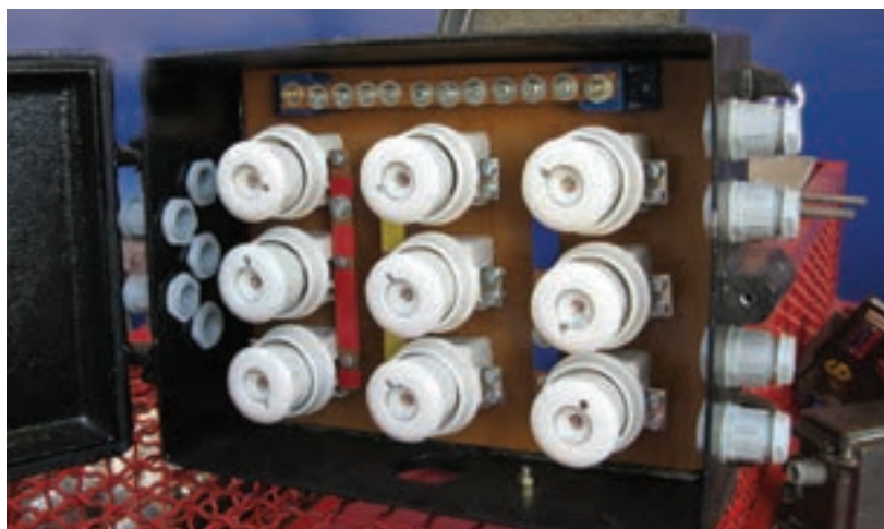
شکل ۷-۱ نمونه‌هایی از تابلوهای فیوز
