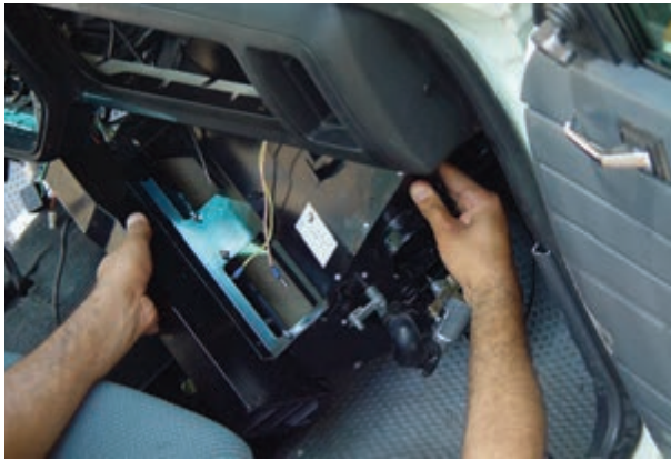
شکل ۴-۳۴- خارج کردن بخاری از محل نصب آب
