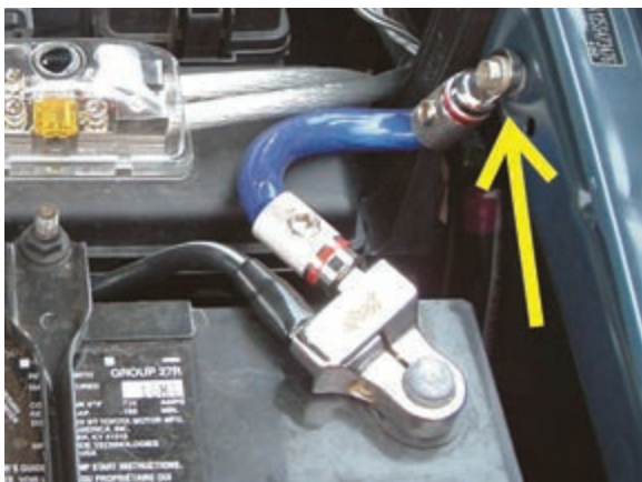
شکل ۲-۲۴ اتصال کابل منفی باتری به بدنه
