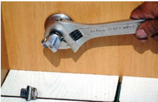
شکل ۳-۲۵۴- سفت کردن شیر پیسوار
