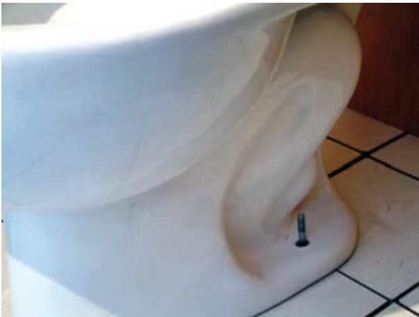
شکل ۲۴۸-۳- قرار دادن توالت فرنگی در محل خود
