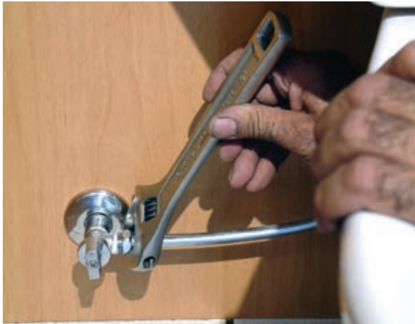
شکل ۲۵۶-۳- سفت کردن مهره‌ی شیر پیسوار
