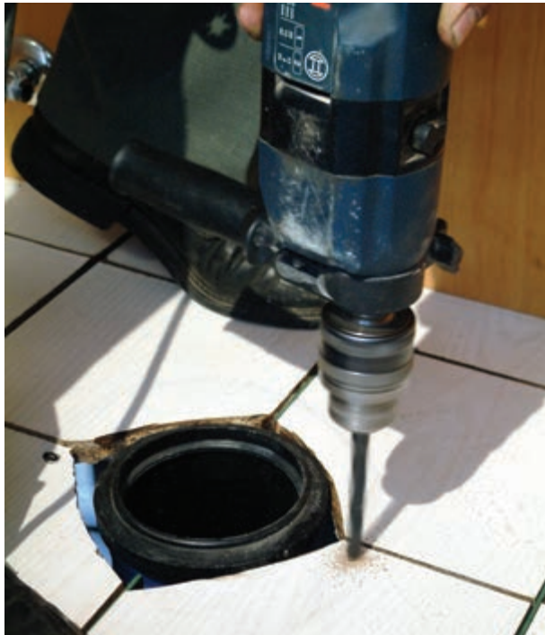
شکل ۲۴۶-۳- سوراخ‌کاری محل‌های علامت‌گذاری شده
