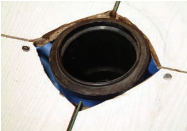
شکل ۲۴۴-۳- قرار دادن بوگیر در داخل زانویی
