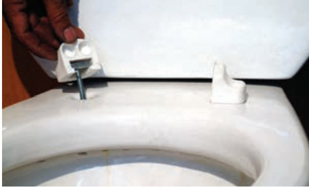
شکل ۳-۲۵۳- اتصال بست‌های نگهدارنده به توالت فرنگی
