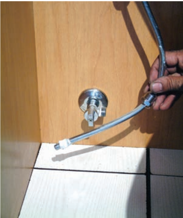
شکل ۳-۲۵۵- خمکاری لوله‌ی پیسوار
