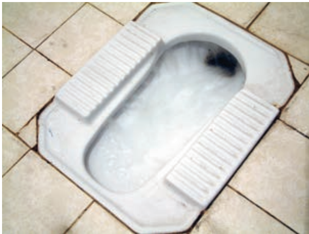
ب - عمل تخلیه شدن آب درون مخزن فشاری به درون کاسه توالت
