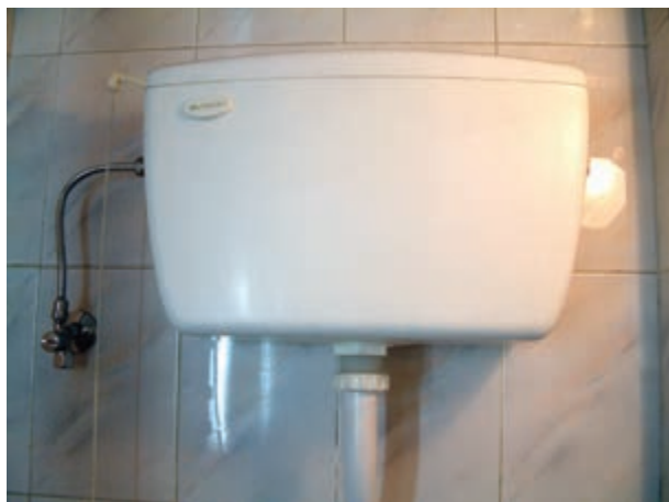
نصب مخزن فشاری
