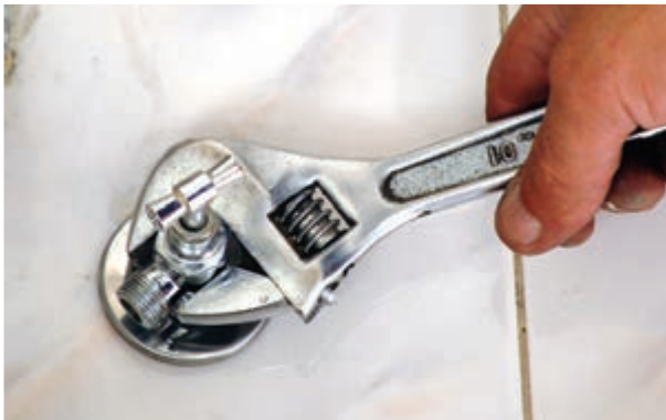
شکل ۲۲۰-۳ سفت کردن شیر پیسوار با آچار فرانسه
