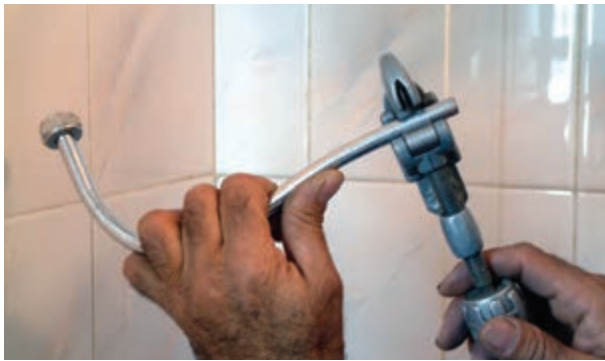
شکل ۲۲۲-۳- بریدن لوله‌ی پیسوار به وسیله‌ی لوله‌بر
