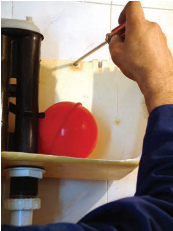
شکل ۲۱۳-۳- نصب مخزن فشاری به دیوار
