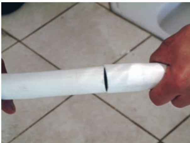
شکل ۲۰۶-۳- جا زدن لوله‌های تخلیه در درون یکدیگر
