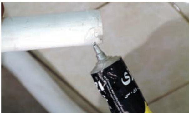
شکل ۲۰۵-۳- زدن چسب به لوله‌های تخلیه
