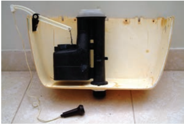
شکل ۳-۲۰۷- نصب پمپ تخلیه درون مخزن فشار
