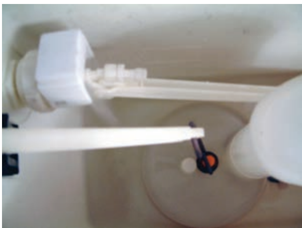
شکل ۲۲۴-۳- پر شدن مخزن فشاری
