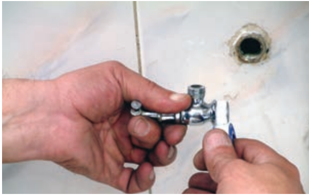
شکل ۲۱۹-۳ پیچیدن نوار تفلون به دندهی \frac{3}{4} شیر پیسوار
