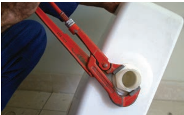
شکل ۳-۲۰۸- سفت کردن مهره‌ی پمپ تخلیه
