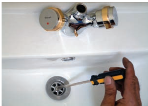
شکل ۳-۴۰ نصب زیراب بر روی دستشویی
