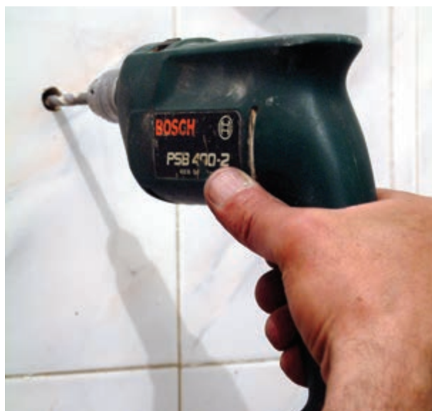
شکل ۳-۴۱ سوراخ‌کاری محل نصب پیچ‌ها
