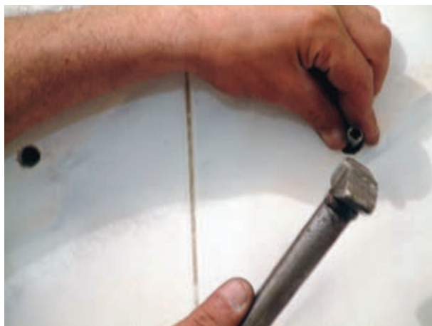
شکل ۳-۴۲ کوبیدن رولپلاک‌ها در درون سوراخ‌ها
