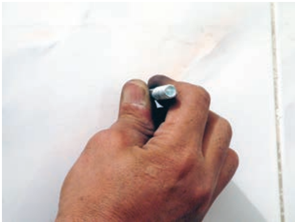
شکل ۳-۴۳- بستن پیچ‌ها در درون رولپلاک‌ها با دست
