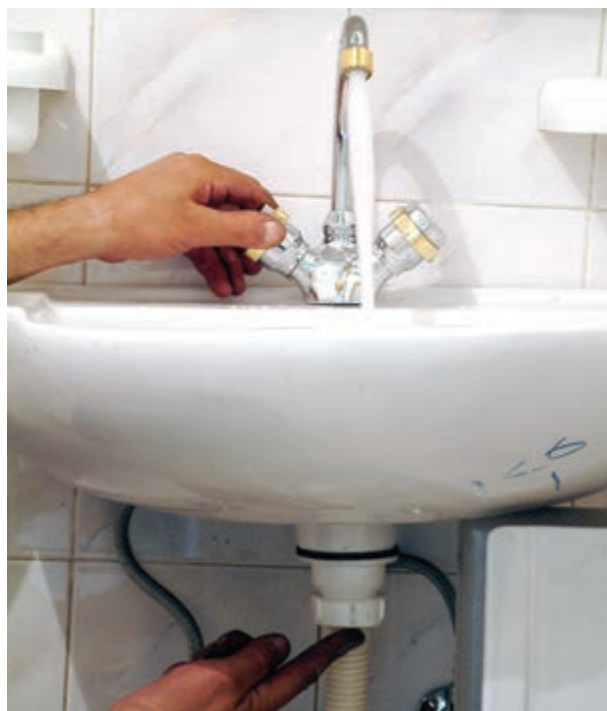
شکل ۳-۵۷- عمل کنترل نشت آب از محل‌های اتصال
