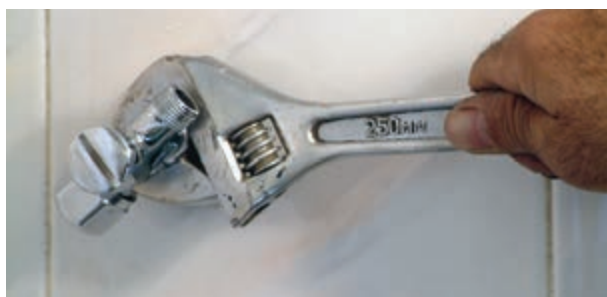
شکل ۳-۴۸ سفت کردن شیر پیسوار با آچار فرانسه
