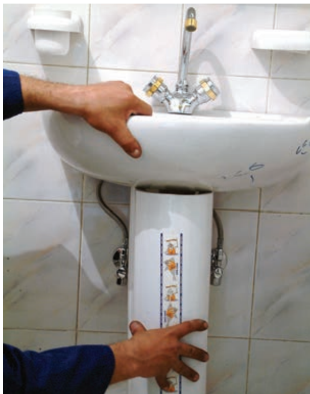
شکل ۳-۵۸- قرار دادن پایه‌ی دست‌شویی در زیر آن
