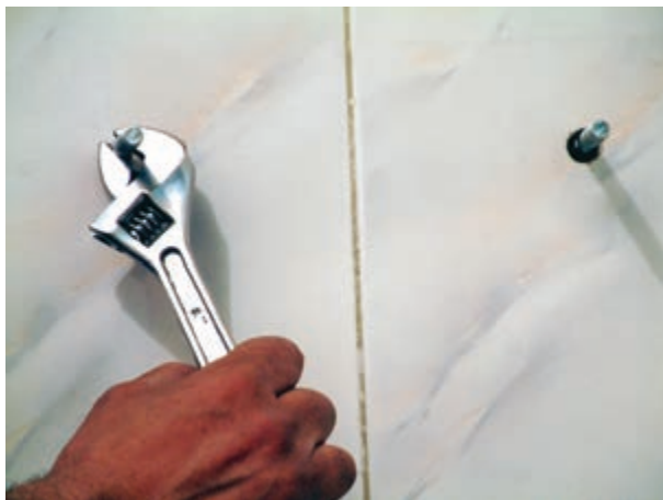
شکل ۳-۴۴- سفت کردن پیچ‌ها در درون رولپلاک‌ها
