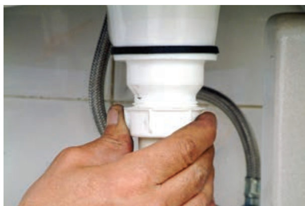
شکل ۳-۵۶- بستن مهره‌ی لوله‌ی عمودی سیفون به زیراب
