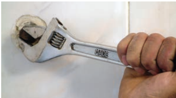
شکل ۱۸۲-۲- بازکردن درپوش‌ها
