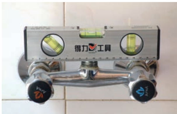
شکل ۱۷۴-۲- سنجش تراز بودن شیرمخلوط دیواری
