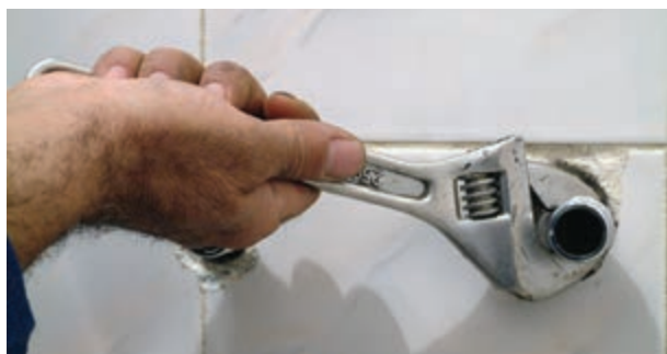
شکل ۱۶۷-۲ سفت کردن دنباله‌ها با آچار فرانسه
