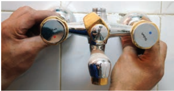
شکل ۲-۲۰۵- بستن مهره‌های شیر مخلوط دوش با دست
