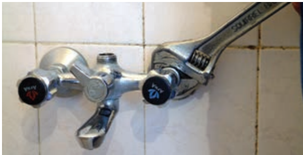
شکل ۲-۲۰۶- سفت کردن مهره‌های شیر با آچار
