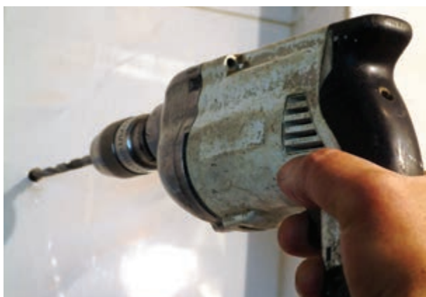
شکل ۱۹۲-۲- سوراخ کردن محل نصب بست آویز
