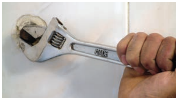
شکل ۱۹۸-۲- باز کردن درپوش‌ها
