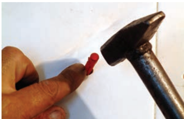
شکل ۱۹۳-۲- کوبیدن رولپلاک درون سوراخ
