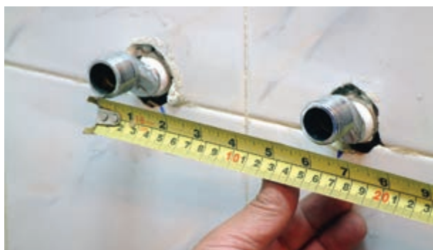
شکل ۱۶۸-۲ کنترل اندازه‌ی محور تا محور دنباله‌ها
