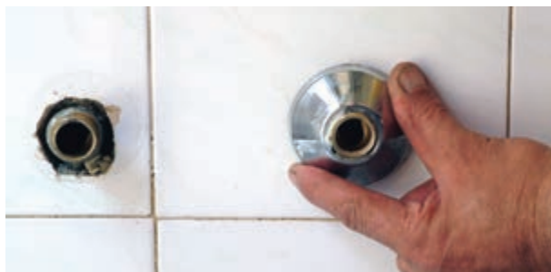
شکل ۲-۱۸۷- اتصال کاسه‌ها به دنباله‌ها
