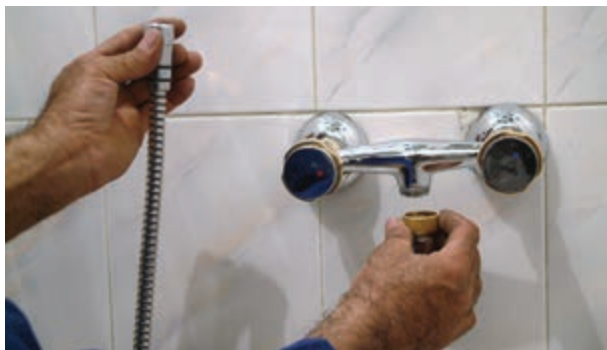
شکل ۱۹۱-۲- اتصال شیلنگ آفتابه به شیر مخلوط توالت
