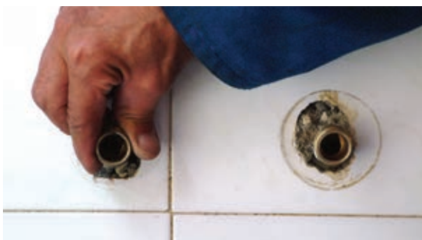
شکل ۱۸۴-۲- بیچیدن دنباله‌ها به محل نصب شیر
