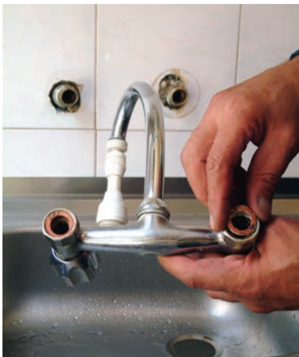
شکل ۲-۱۷۱- قراردادن واشر درون مهره‌ی تنه شیرمخلوط
