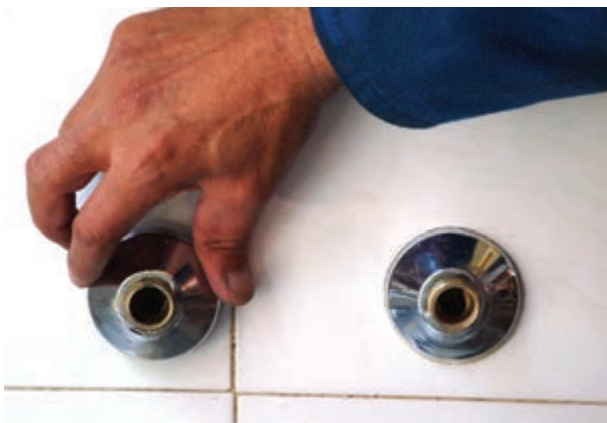
شکل ۲-۱۷۰- بستن کاسه‌ها به دنباله‌ها با دست
