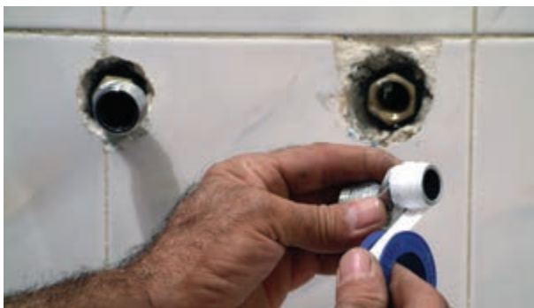
شکل ۱۸۳-۲- بیچیدن نوار تفلون به دنباله‌ها
