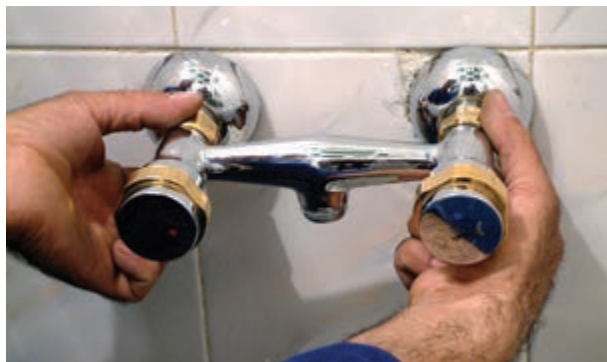
شکل ۲-۱۸۸- اتصال شیر مخلوط توالت به دنباله‌ها
