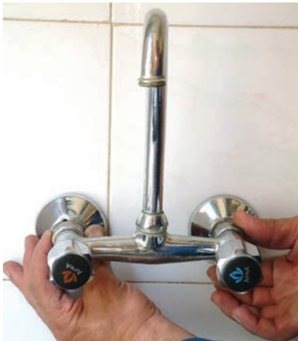
شکل ۱۷۲-۲- پیچیدن مهره‌ها به دنباله‌های شیر مخلوط
