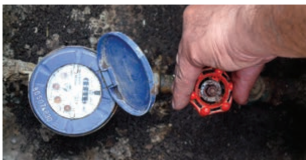
شکل ۱۹۵-۲- باز کردن شیرفلکه‌ی اصلی
