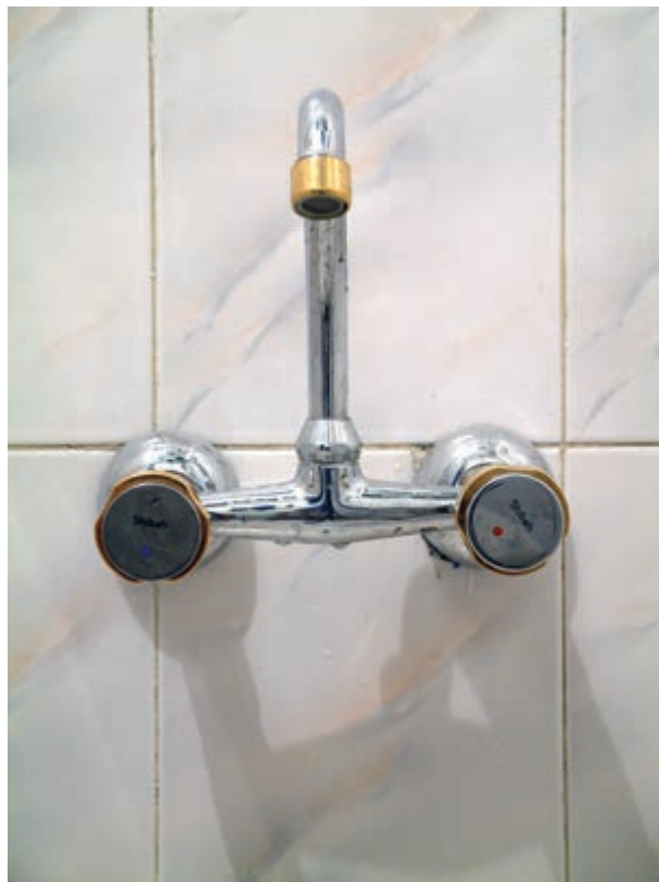
نصب شیر مخلوط دیواری
