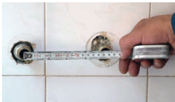
شکل ۲-۲۰۲- کنترل نمودن فاصله‌ی دنباله‌ها به وسیله‌ی متر
