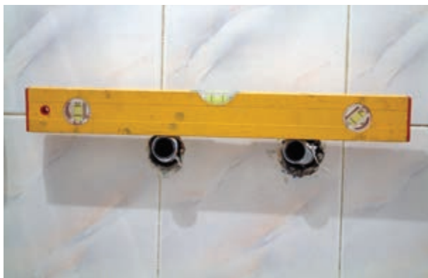
شکل ۲-۱۶۹- کنترل صاف بودن دنباله‌ها
