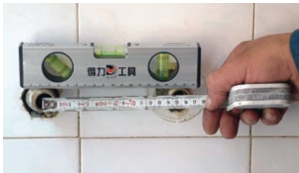
شکل ۲-۱۸۶- کنترل صاف بودن و اندازه‌ی دنباله‌ها
