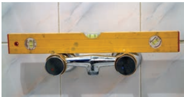
شکل ۱۹۰-۲- سنجش تراز بودن شیر مخلوط
