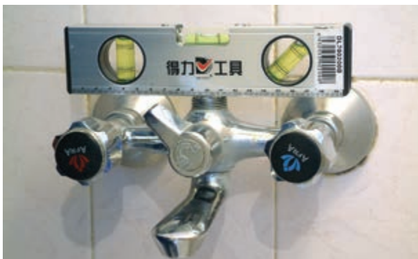
شکل ۲-۲۰۷- سنجش تراز بودن شیر مخلوط دوش
