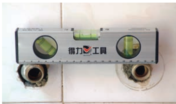
شکل ۲-۲۰۳- کنترل ترازبودن دنباله‌ها
