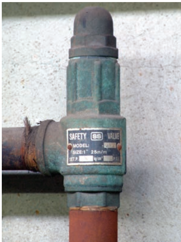
شکل ۲-۱۰۶- شیر اطمینان حساس در برابر فشار
