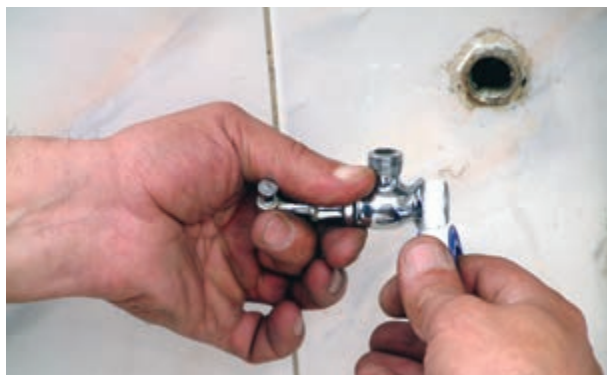
شکل ۱۴۲-۲ پیچیدن نوار تفلون به دنده‌ی \frac{3}{4} شیر پیسوار
