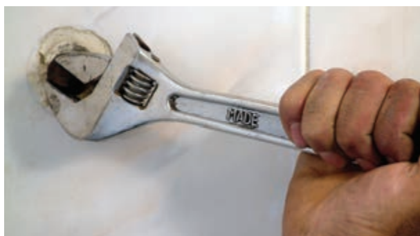
شکل ۱۴۱-۲ باز کردن درپوش
