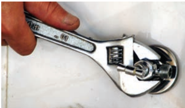
شکل ۱۴۴-۲- سفت کردن شیر پیسوار با آچار فرانسه
