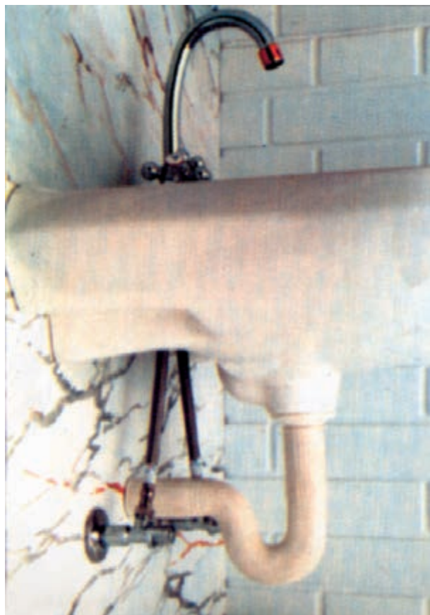
شکل ۱۸-۲ - اتصال شیرهای پیسوار به وسیله شیلنگ‌های فشار قوی دو سر مهره به شیر مخلوط توکاسه
