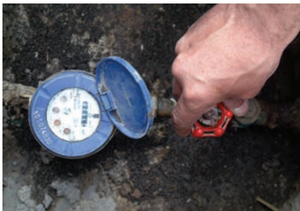
شکل ۲-۶۰- بستن شیر فلکه‌ی اصلی آب ساختمان
