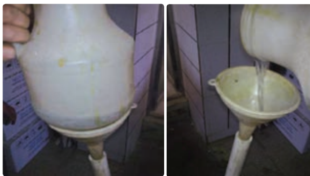
شکل ۱۸-۵- شست‌وشوی مبدل بعد از رسوب‌زدایی
