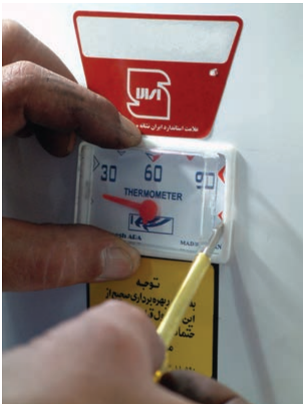
شکل ۱-۱۱۶- جدا کردن ترمومتر
