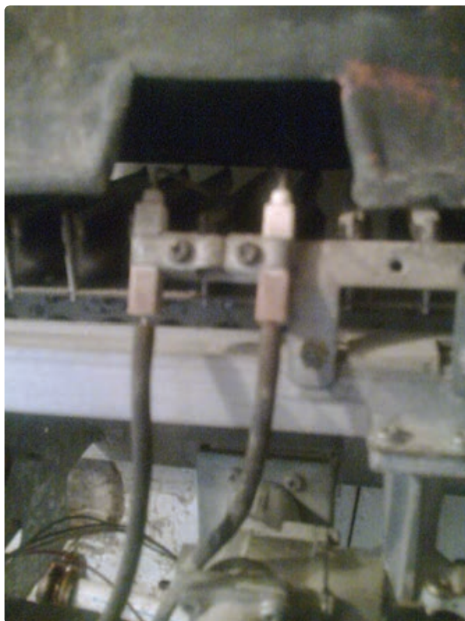
شکل ۲-۱- آب گرم کن دیواری بدون شمعک
