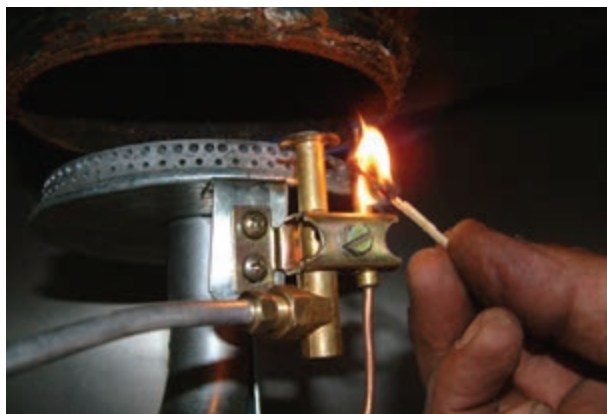
شکل ۱-۱۰۵ مشتعل کردن شمعک به وسیله‌ی شعله‌ی کبریت
