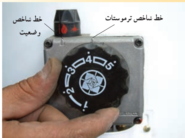
شکل ۱۱۰- تغییر کلید تنظیم دما (ترموستات)
