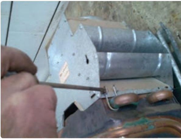
شکل ۶-۱ جدا کردن کلاهک تعدیل از مبدل
