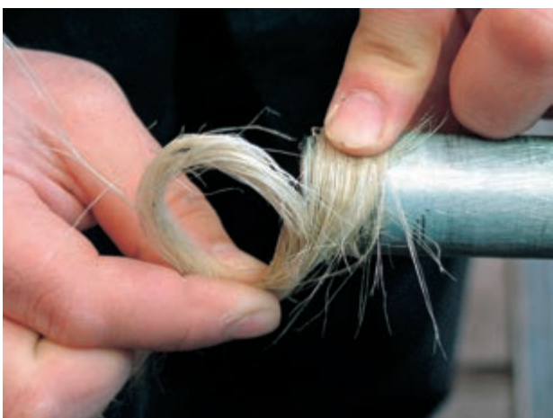
شکل ۱۳۸-۵- پیچیدن مواد آب‌بندی به سردنده‌ها
