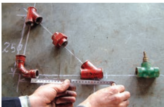
شکل ۱۳۴-۵- اندازه‌گیری لوله‌های مورد نیاز
