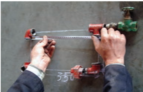
شکل ۱۴۹-۵- اندازه گیری طول لوله ها
