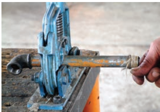
شکل ۵-۱۵۳- خمیر و کنف کردن سردنده‌ی بعدی
