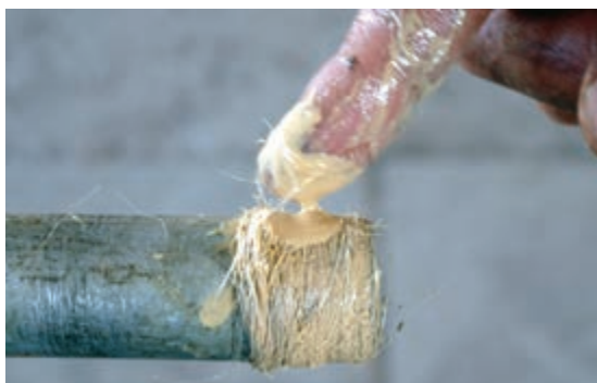
شکل ۵-۱۵۲- خمیر و کنف کردن سردنده‌ها
