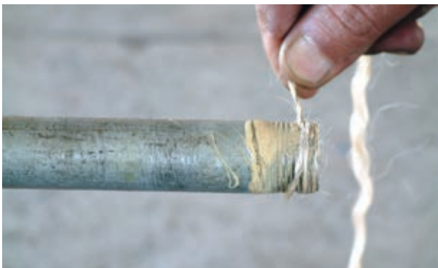
شکل ۵-۵۴- پیچیدن کنف بر روی سردنده
