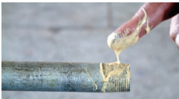
شکل ۵-۵۳- مالیدن خمیر بر روی سردنده
