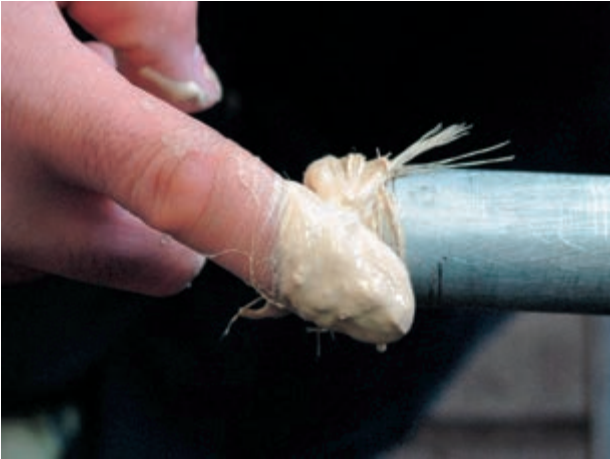
شکل ۹۰-۵- خمیر و کنف کردن سردنده
