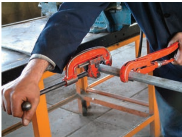
شکل ۱۱۶-۵- ادامه‌ی برش‌کاری لوله
