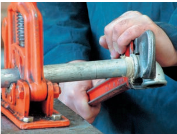
شکل ۹۲-۵- سفت کردن فیتینگ به وسیله‌ی آچار لوله‌گیر
