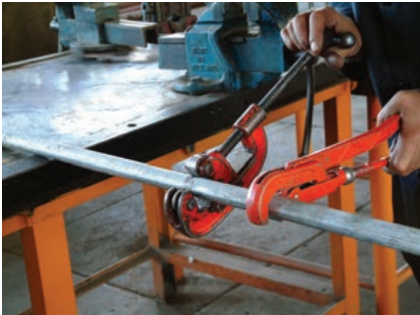
شکل ۱۱۵-۵- شروع برش‌کاری لوله بدون استفاده از گیره لوله
