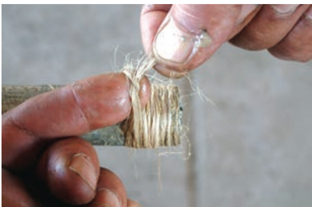
شکل ۵-۵۵- گره زدن انتهای پیچیدن کنف
