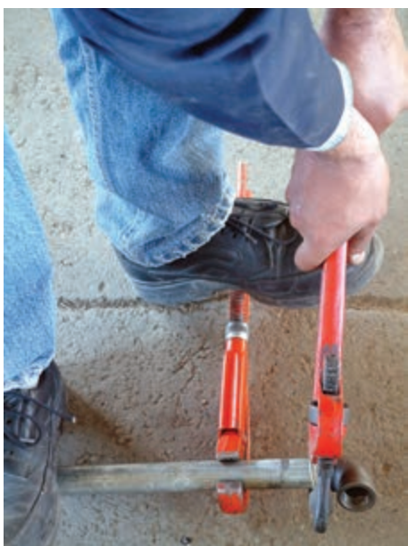
شکل ۱۲۵-۵- نحوه‌ی سفت کردن فیتینگ به لوله به وسیله‌ی دو عدد آچار لوله‌گیر
