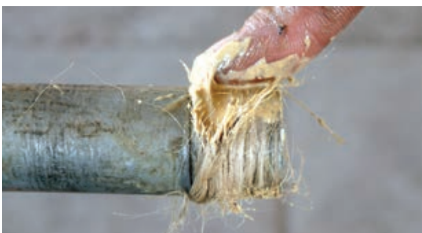
شکل ۵-۵۷- مالیدن خمیر آب بندی بر روی کنف
