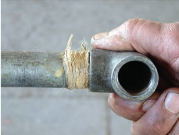
شکل ۹۱-۵- بستن فیتینگ بر روی سردنده
