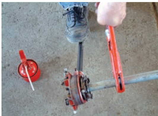
شکل ۱۲۰-۵- عمل حدیده کاری لوله
