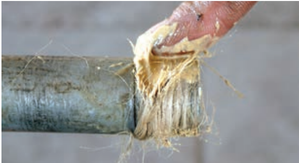
شکل ۵-۱۰۰- استفاده از مواد آب‌بندی
