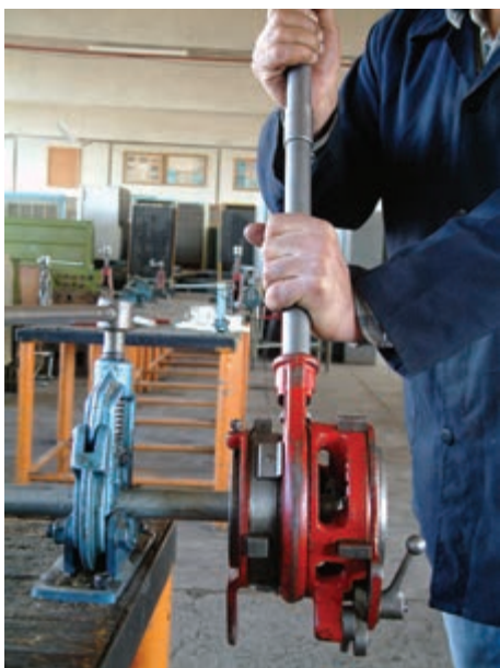
شکل ۱۲۶-۴- باز کردن حدیده از لوله
