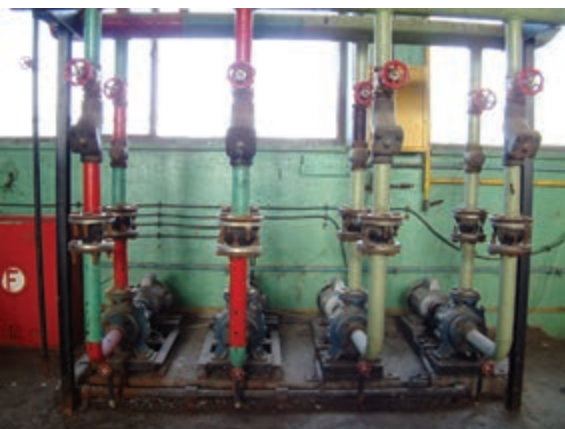
شکل ۳-۵- کاربرد لوله درزدار در لوله‌کشی شوفاژ
