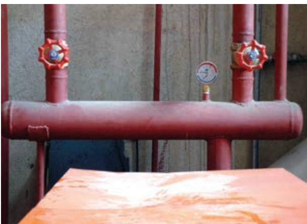
شکل ۳۲-۵- استفاده از اتصال جوشی در حرارت مرکزی
