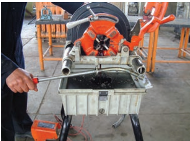
شکل ۱۳۳-۴ عمل حدیده کاری لوله
