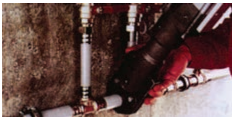
شکل ۲۳-۵ - اتصال پرسی
