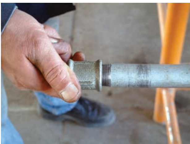
شکل ۴-۴۱- کنترل بار سردنده به وسیله‌ی یک فیتینگ
