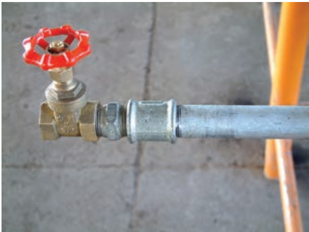
شکل ۴-۸- اتصال دنده‌ای
