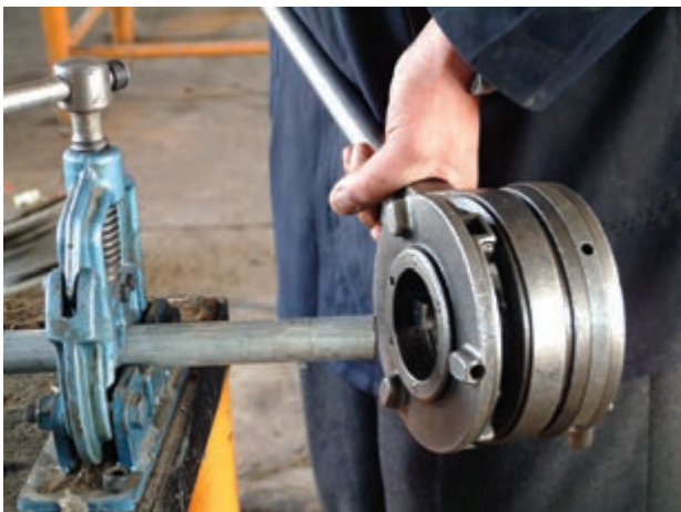
شکل ۴-۶۳- شروع حدیده کاری
