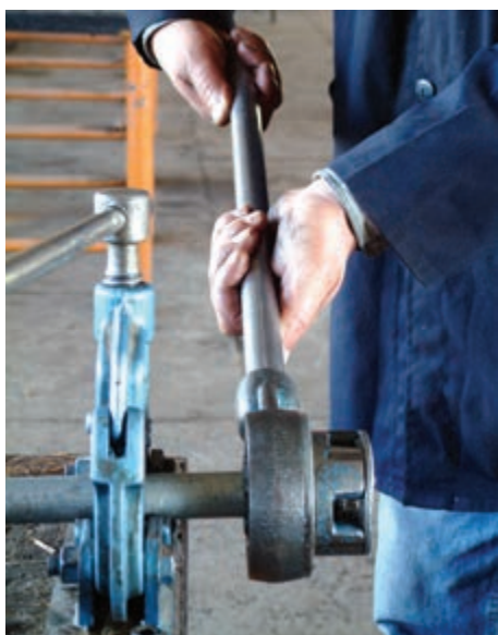
شکل ۴-۵۰- باز کردن حدیده از لوله
