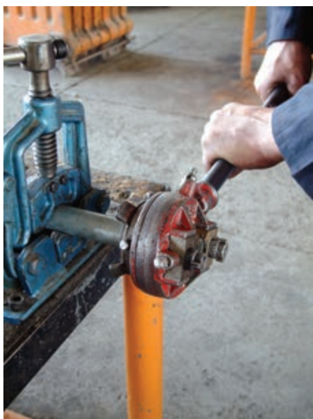
شکل ۳۴-۴- حدیده کردن لوله
