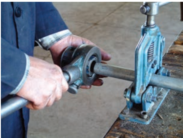
شکل ۴-۴۵- شروع حدیده کاری
