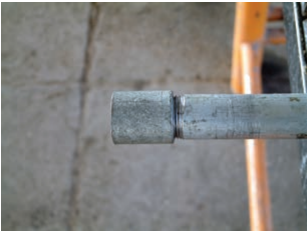
شکل ۱۵-۴ اتصال بوشن فلزی بدون لبه به سردنده‌ی لوله
