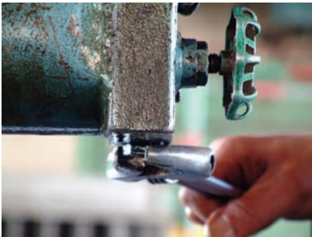
شکل ۱۴-۳- باز کردن درپوش تخلیه ی روغن
