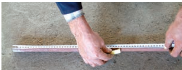
شکل ۳-۵۴- خط کشی لوله و تعیین محل‌های خم
