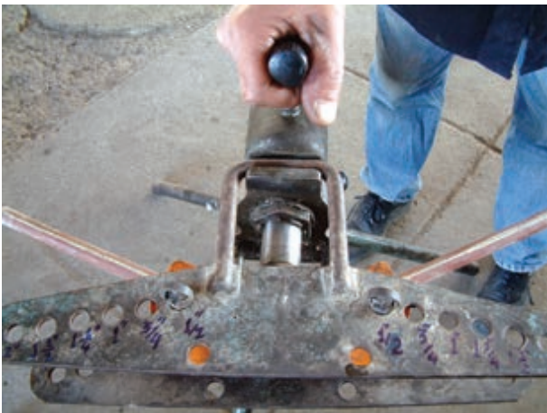
شکل ۳-۲۴- عمل خم کاری لوله های فولادی به وسیله ی خم کن هیدرولیکی
