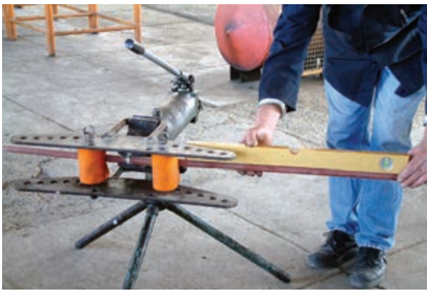
شکل ۳-۴۳- کنترل افقی بودن لوله در خم کاری
