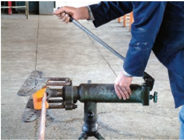
شکل ۱۱-۳- شروع خم کاری
