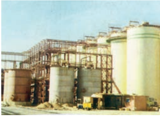
شکل ۱-۳۹- تأسیسات نفتی در جنوب
