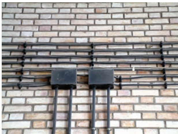
شکل ۵-۵۷- کابل‌کشی روی دیوار
