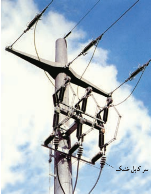
شکل ۶-۶- سر کابل خشک حرارتی هوایی
