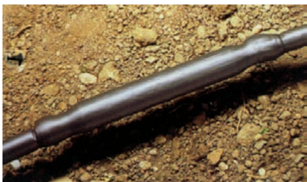
ج- وضعیت روکش پس از عملیات
