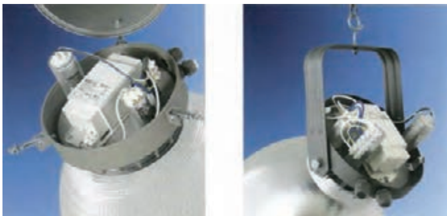
شکل ۲-۳۱ - اتصال خازن به لامپ
